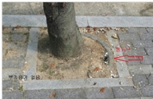
동일 도로 구간내 뿌리성장유도기 설치, 미설치 구간 2년 후의 비교에서 미설치 구간의 뿌리용기 재발생으로 도로포장을 파괴중인 현장
